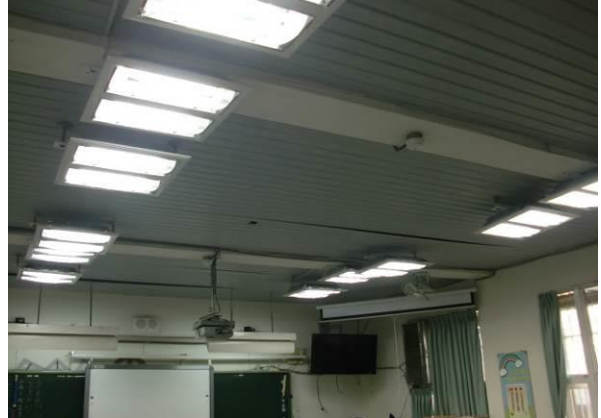
更換省電照明燈管－教室
