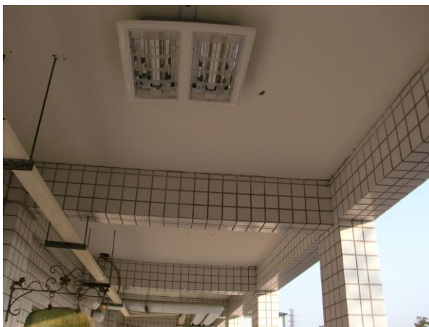
更換省電照明燈管－走廊
