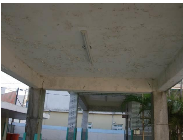
更換省電 LED 燈管－廁所旁走道
