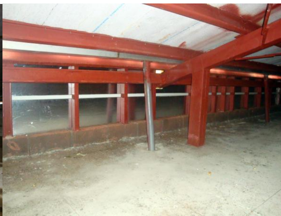
斜屋頂修繕後的狀況
