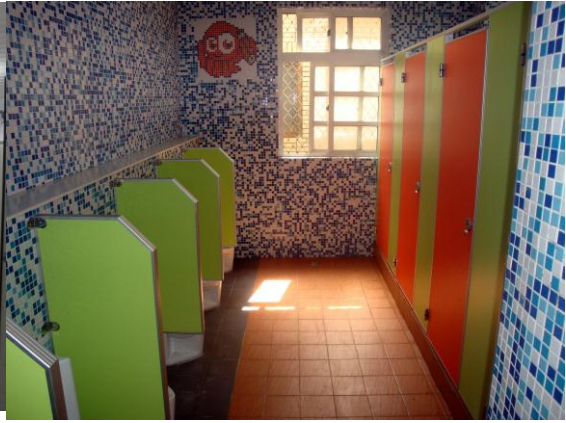
廁所修繕後的狀況
