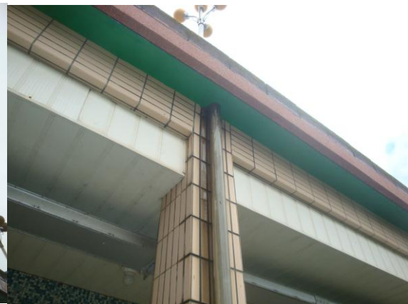
屋頂修繕後的狀況
