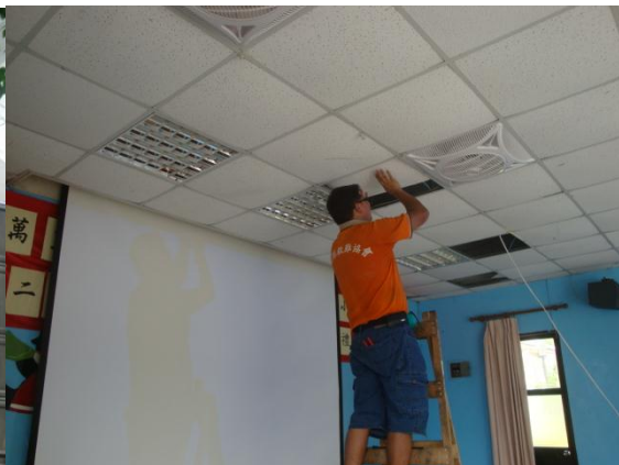
加裝循環扇空氣好流通
