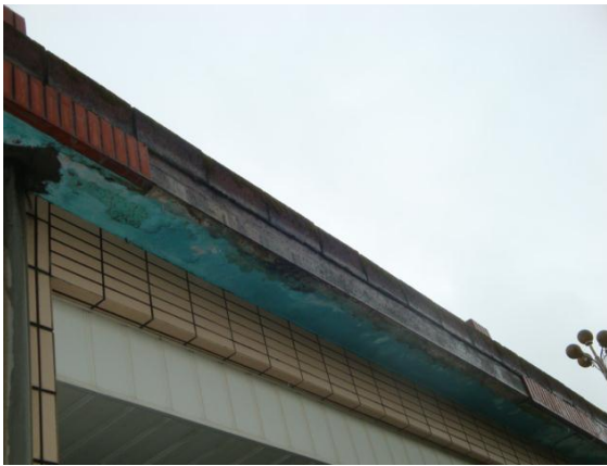
屋頂修繕前的狀況
