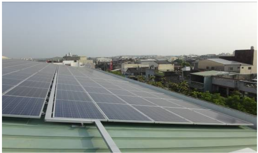
照片說明：裝設太陽能光電板
