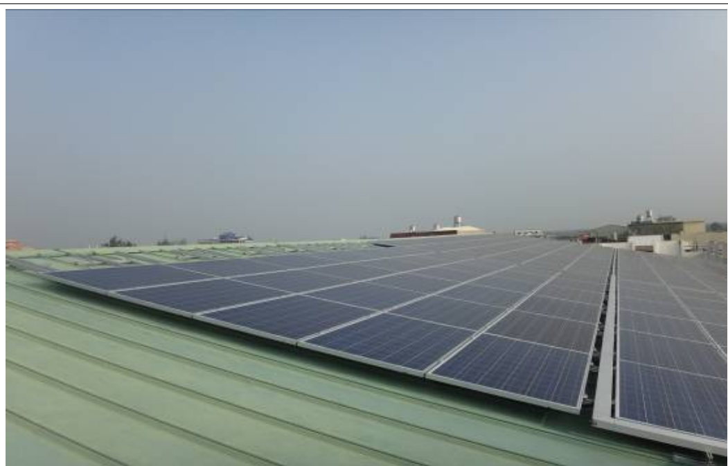
照片說明：裝設太陽能光電板
