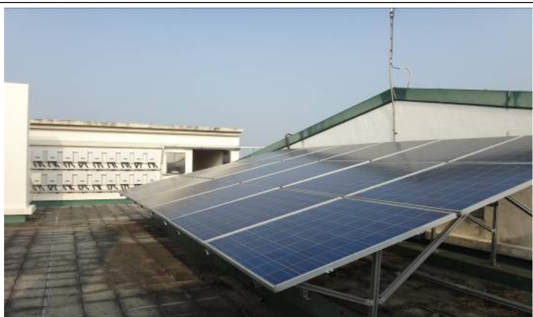
照片說明：裝設太陽能光電板
